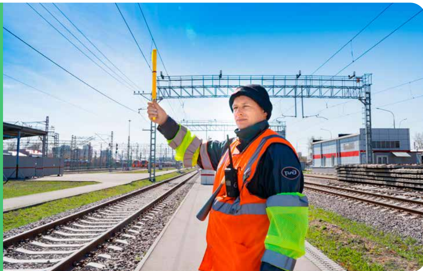
Дмитрий Сюрко, монтёр пути, обеспечивает безопасность производства работ (Московско-Окружная дистанция инфраструктуры)
