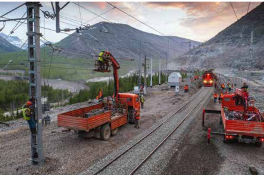
Строительные работы на БАМе
